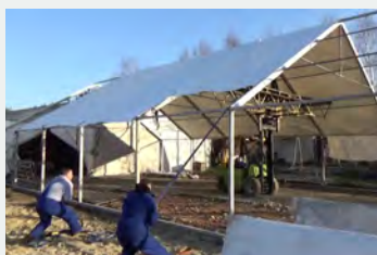
WCIĄGANIE BRYT MATERIAŁU PVC
